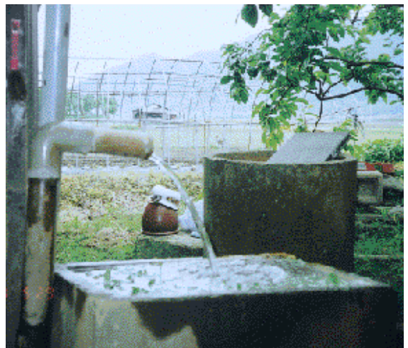
飲み水だけ金気を取るために丸い井戸の中に木炭、しゅろの皮、砂を入れて濾(こ)しました(城東)
