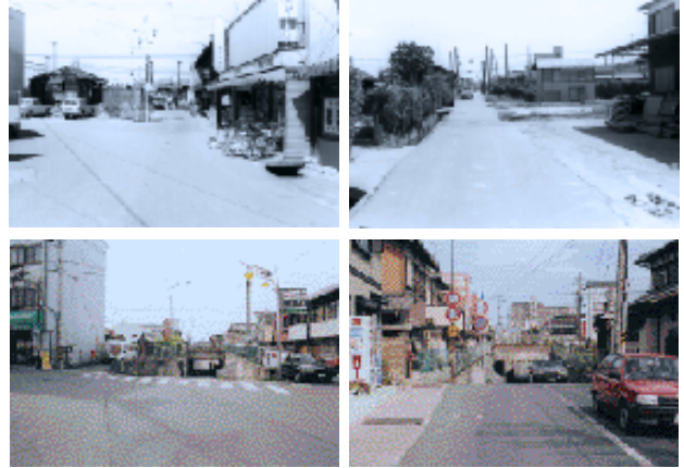
工事着工前(上段・昭和49年)と現在の様子(下段・平成9年)
