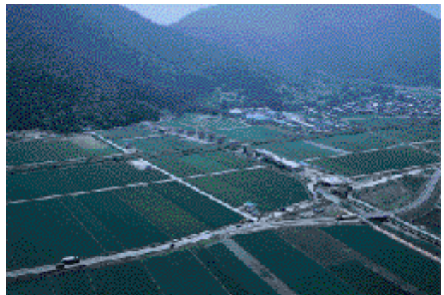
きぬがさ山トンネル工事(平成9年6月)
