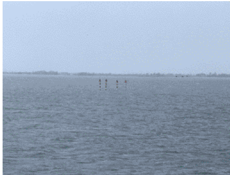
上水揚水地点(長命寺沖の取水口)
