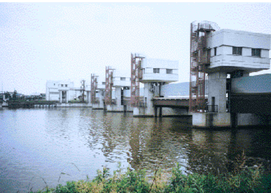
▲栗見新田にある承水湖の水位を調節する近代的な水門
