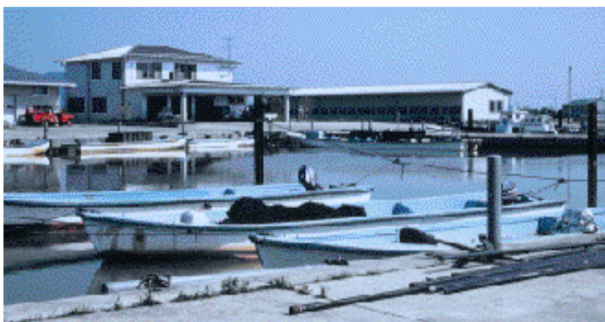
栗見出在家地先に建設された漁業協同組合の建物と漁港
