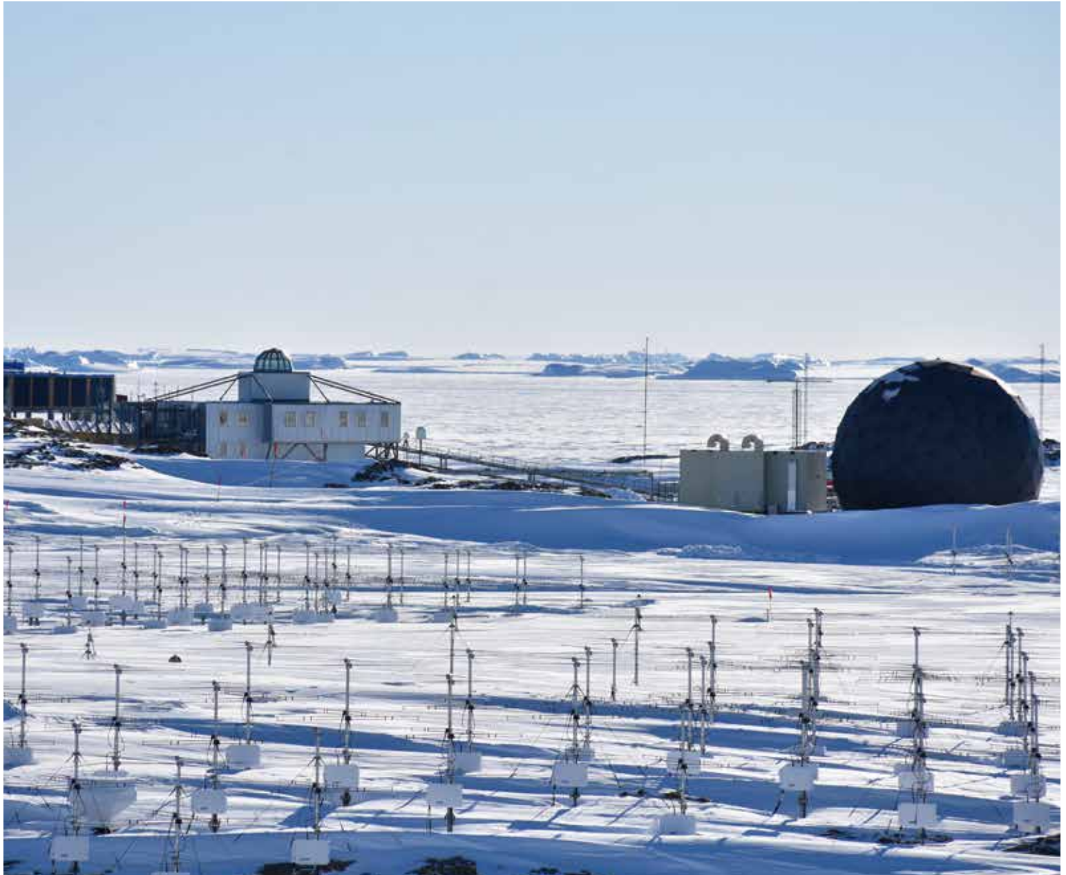
パラボラアンテナを保護するレドーム（右）（国立極地研究所提供）
